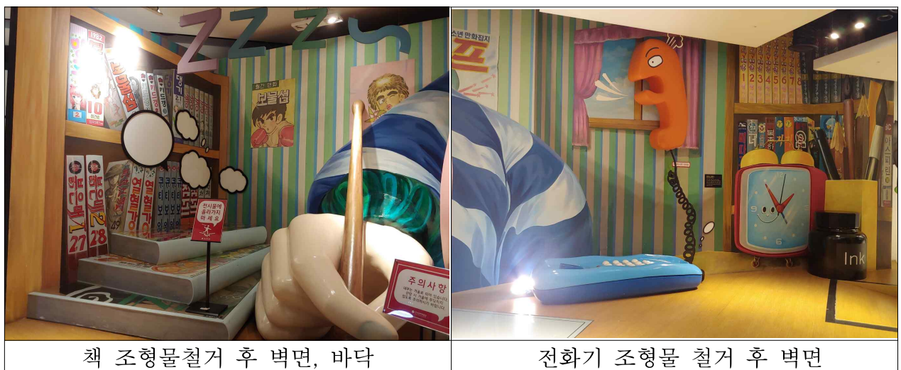
<기존 시설 철거 후 작화 필요 부분>
